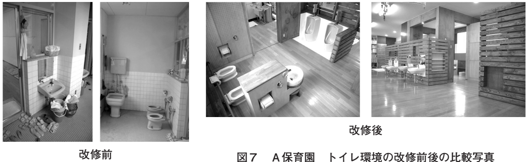
図7 A 保育園 トイレ環境の改修前後の比較写真
